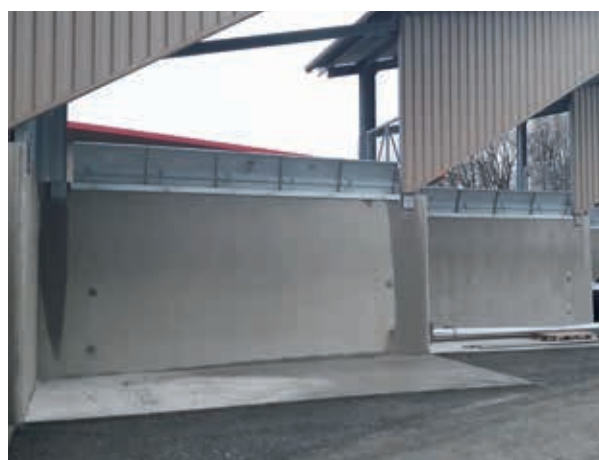
Grands soutènements (Stockage, déchetterie)
