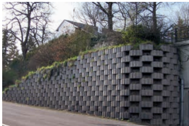
Consolidation de talus
