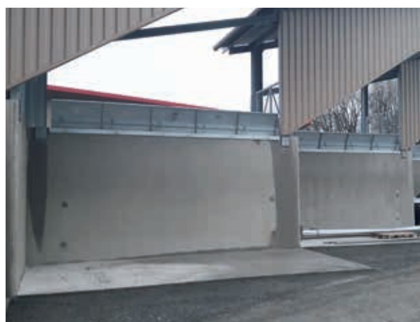
Grands soutènements (Stockage, déchetterie)
