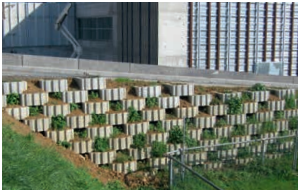
Redressement de talus
