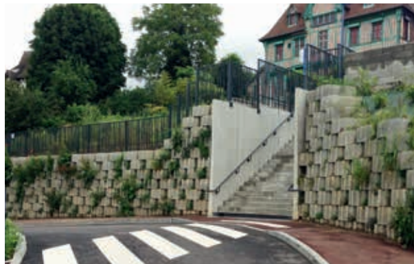
Consolidation de talus
