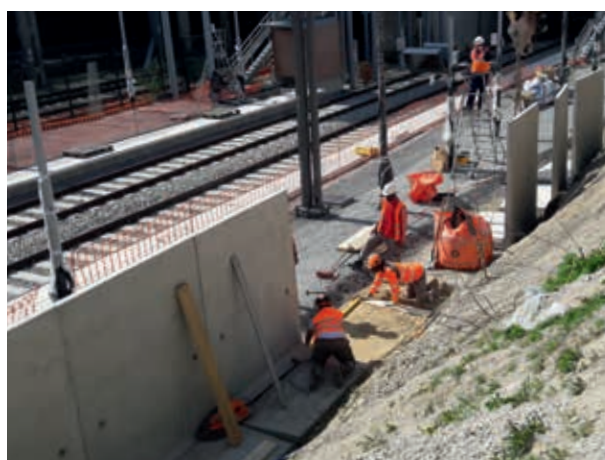
Soutènement de talus de voies ferrées
