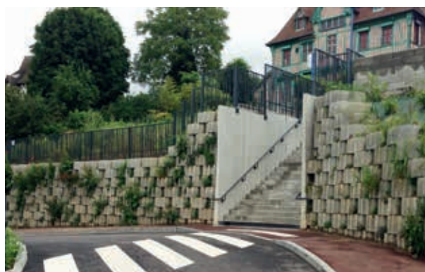
Consolidation de talus
