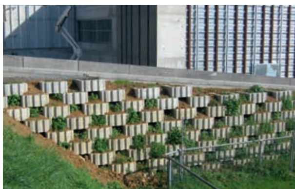
Redressement de talus
