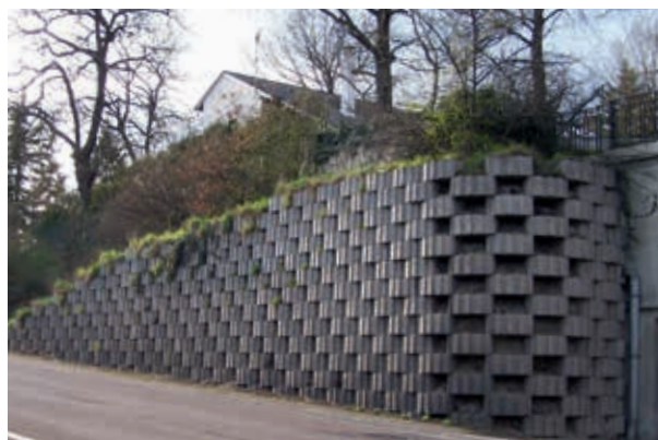
Consolidation de talus
