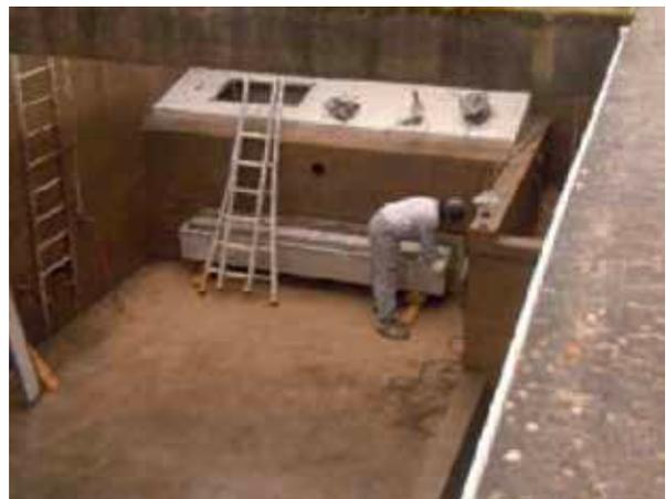
Possibilité d'intégrer des caissons de rinçage autonomes et sans énergie (type Munerez®)
