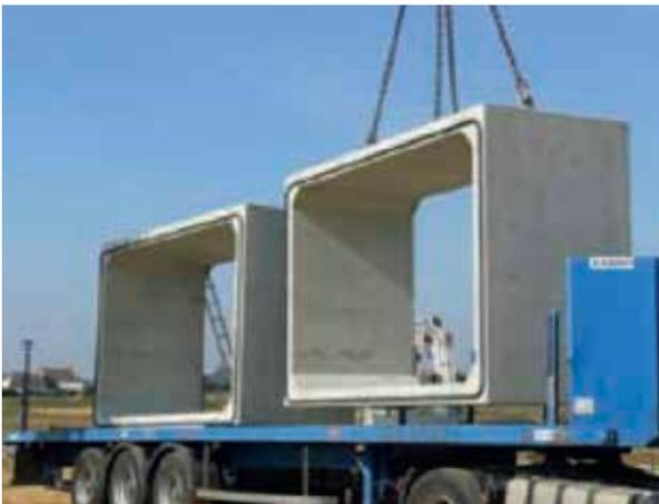
La sécurité des opérations de manutention est assurée au moyen de chaînes à 2 ou 4 brins, mises à disposition par nos soins.
