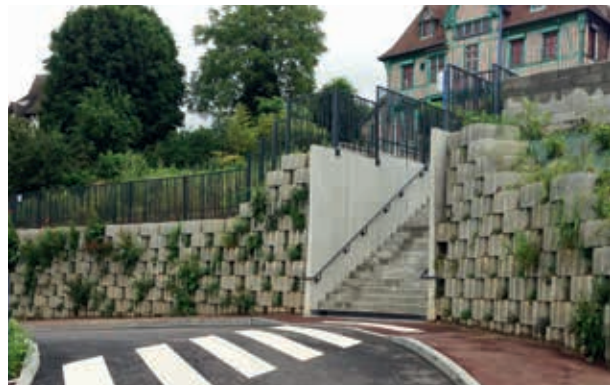
Consolidation de talus
