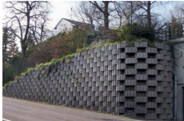
Consolidation de talus
