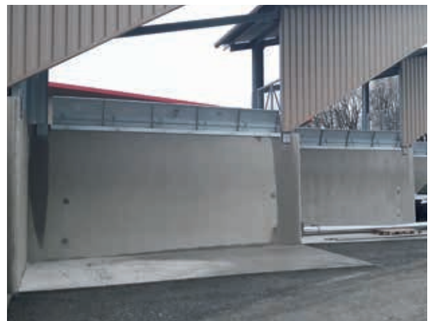
Grands soutènements (Stockage, déchetterie)
