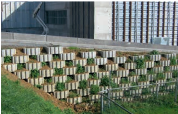
Redressement de talus
