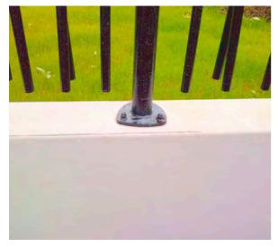
Le béton autoplaçant offre un rendu esthétique haut de gamme avec une finition lisse sur l'ensemble des faces et chants visibles. Afin d'optimiser l'aspect général, les points de manutention sont situés en partie basse du voile les rendant invisibles à l'exploitation. L'ensemble des murs SOTUCITY existent avec résistance renforcée (gamme SOTUCITY-R).
