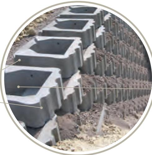
Système autodrainant : l'évidement permet un remplissage de terre ou autres matériaux. L'enracinement profond assure une végétalisation durable
